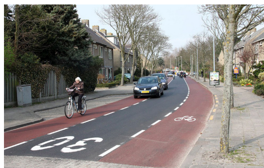
Рис. 2. цветное решение покрытия пешеходной и проезжей части
