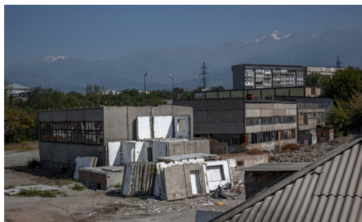
Рис. 6. Автобаза домостроительного комбината в г.Алматы
